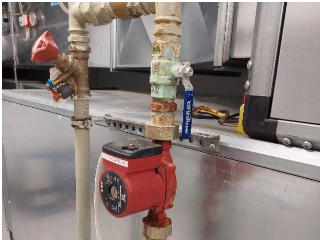
Yleiskuvat lämpöjohtoverkoston sulku- sekä linjasäätöventtiileistä.
