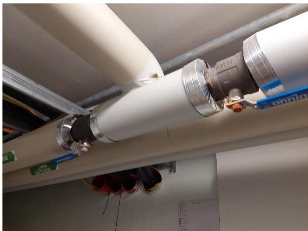
Yleiskuvia käyttövesiverkoston asennuksista ja sulkuventtiileistä.
