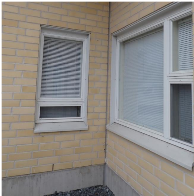
Elastisissa saumoissa ei havaittu puutteita.
