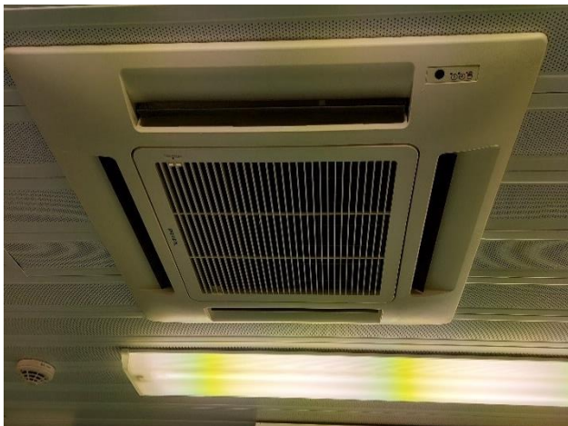
Yleiskuva puhallinkonvektorista.
