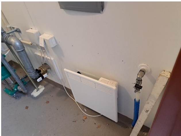
Läpivirtauslämmitin lämmönjakohuoneessa.
