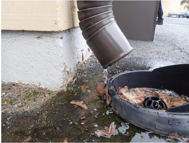
Sadevedet eivät ohjaannu rännikaivoon sprinklerikeskuksen nurkalla
