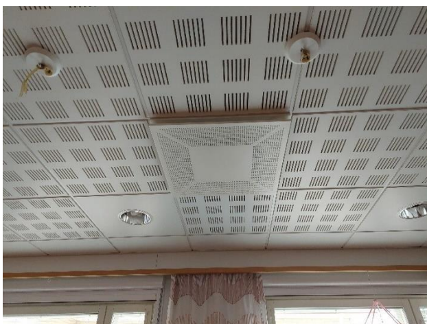
Varatila 0.015 puuttuva ilmanvaihtokanava/-venttiili.
