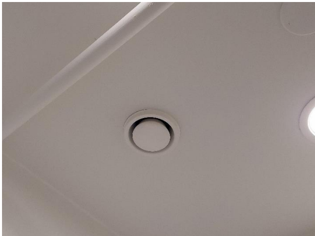
Yleiskuva poistoilmaventtiilistä.
