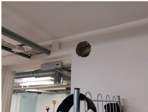
Varatila 0.015 puuttuva ilmanvaihtokanava/-venttiili.
