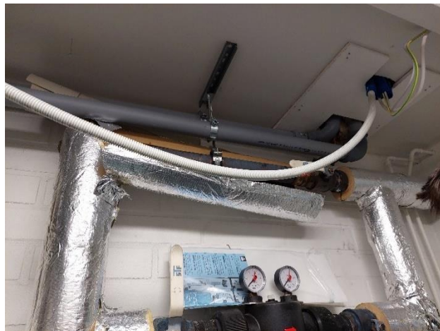
Sprinklerikeskuksessa irronnut putkieriste.
