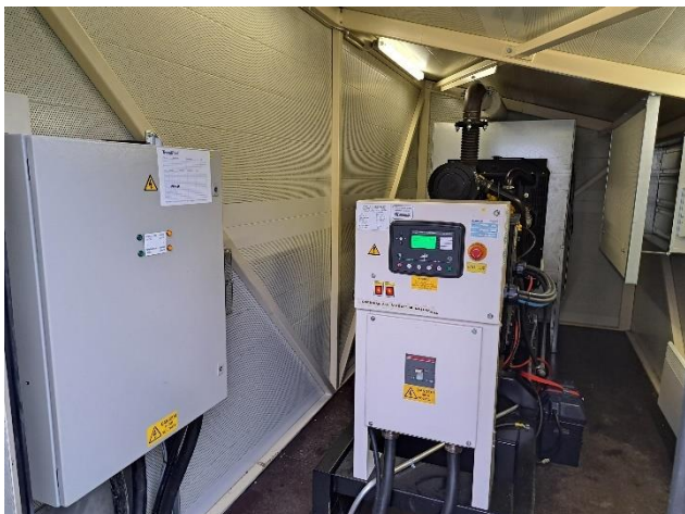
Varavoimakone laitteineen.
