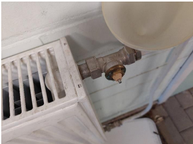
Yleiskuvat alkuperäisestä lämpöpatterista ja rikkoutuneesta patteriventtiilistä.
