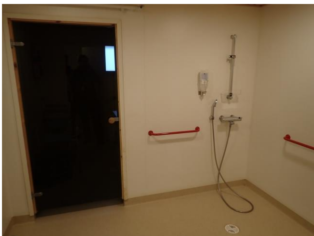
Yleiskuva saunatilan pesuhuoneesta.
