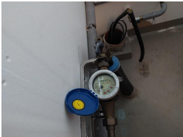
Kiinteistön päävesimittari
