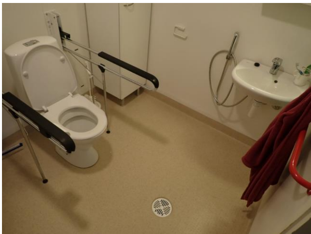
Yleiskuva pesuhuoneesta. Lämmönjakohuone on pesualtaan takana olevan seinän takana.
